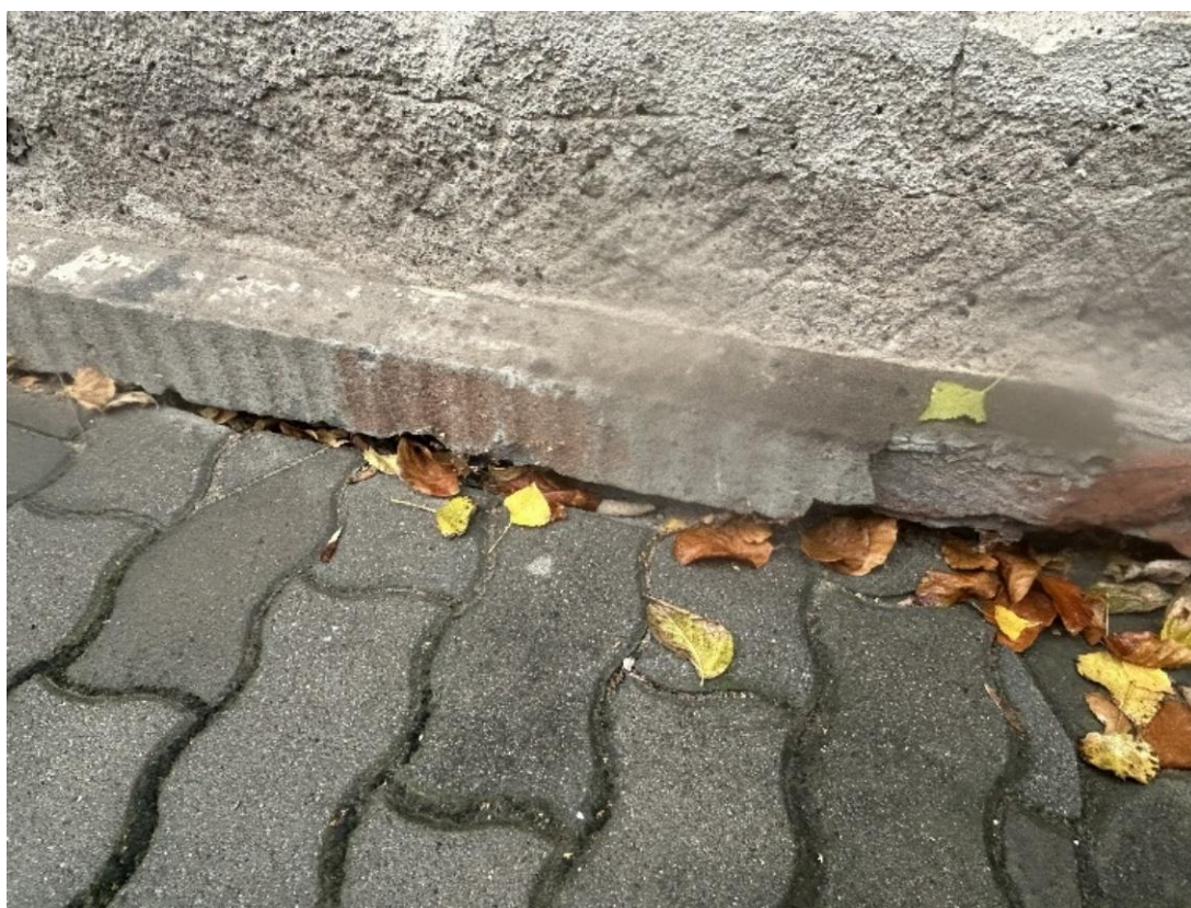
Widoczne ubytki, przetarcia i nieadekwatne, wtórne uzupełnienia na elewacji południowej („C”).
