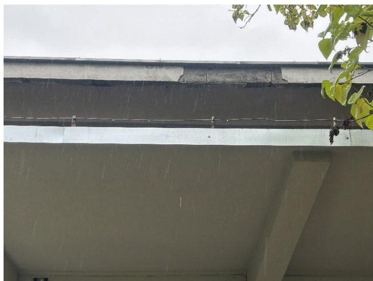
Także widoczne ubytki w tynku okapu na elewacji zachodniej („B”).
