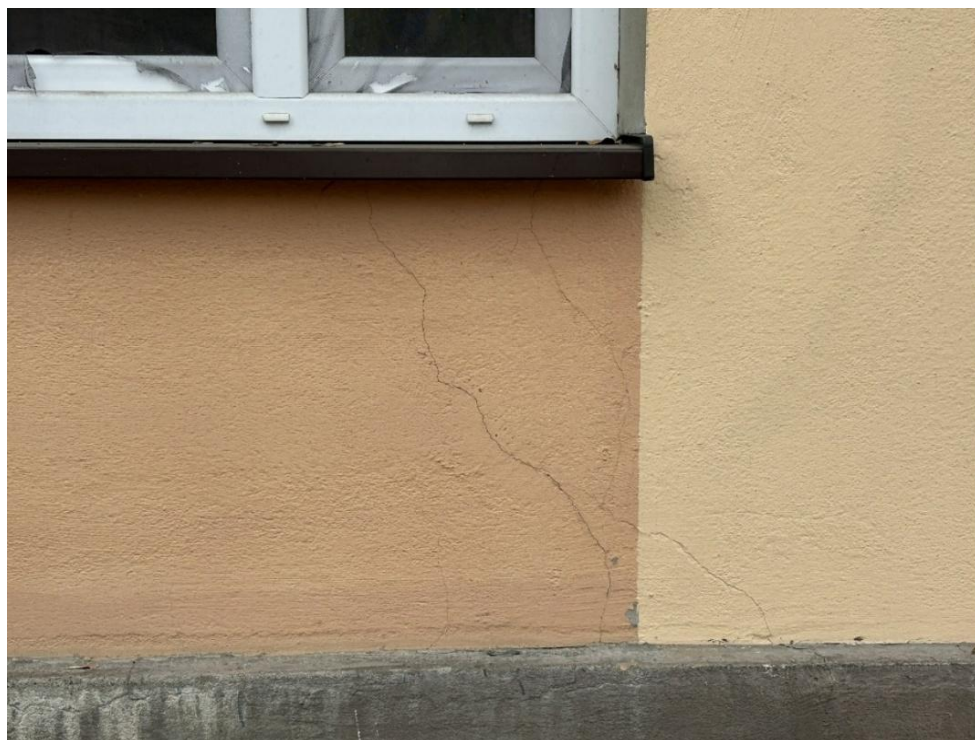
Widoczne skośne rysy pod oknami na elewacji frontowej, wschodniej („ B ”).
