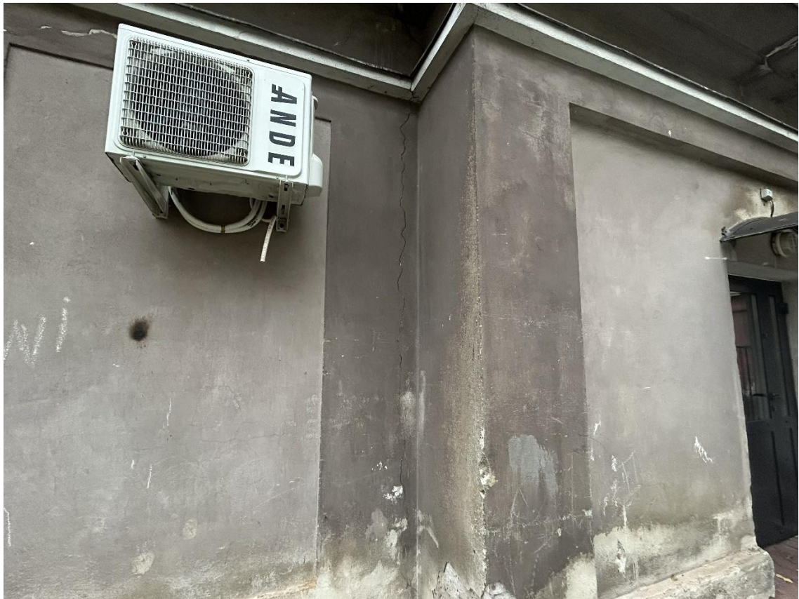
Widoczne spękania od okapu, biegnące w dół i na boki, na elewacji południowej („C”).
