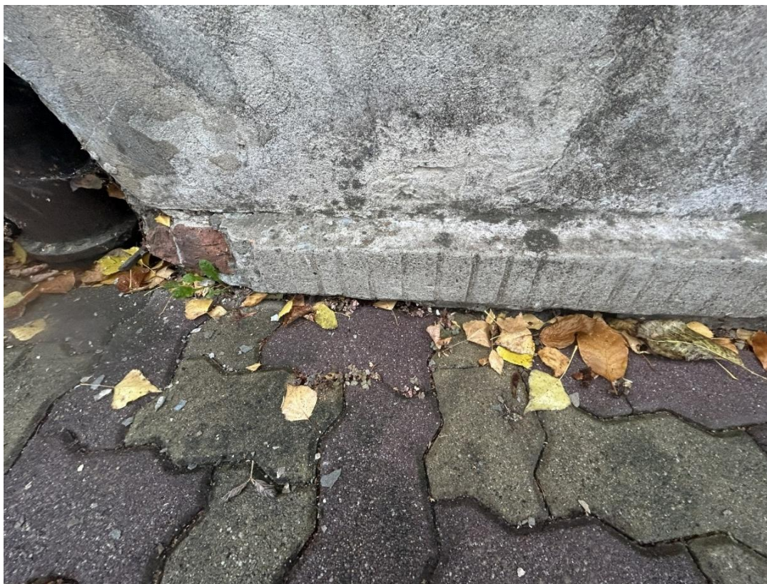
Widoczne duże ubytki w cokole kamiennym przy rynnie spustowej na elewacji północnej („E”).
