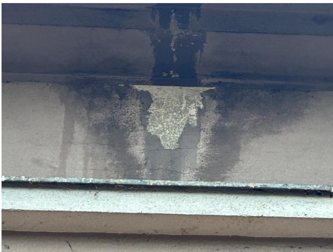
Widoczne zwilgocenia, przemycia, rozległe ubytki oraz korozja biologiczna na profilowanym okapie elewacji frontowej, wschodniej („ B ”).
