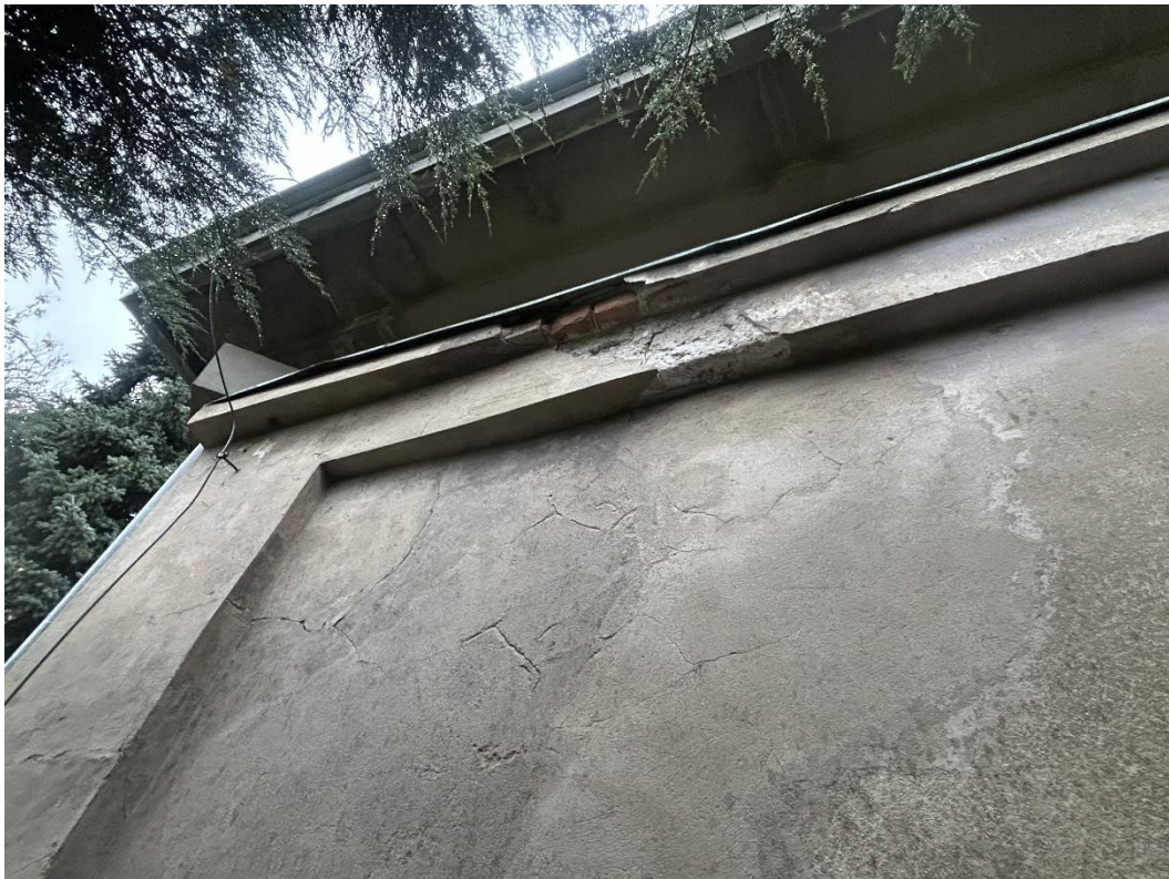
Widoczne bardzo głębokie ubytki sięgające aż do wątku ceglanego na i pod górnym gzymsem, elewacji zachodniej („D”).
