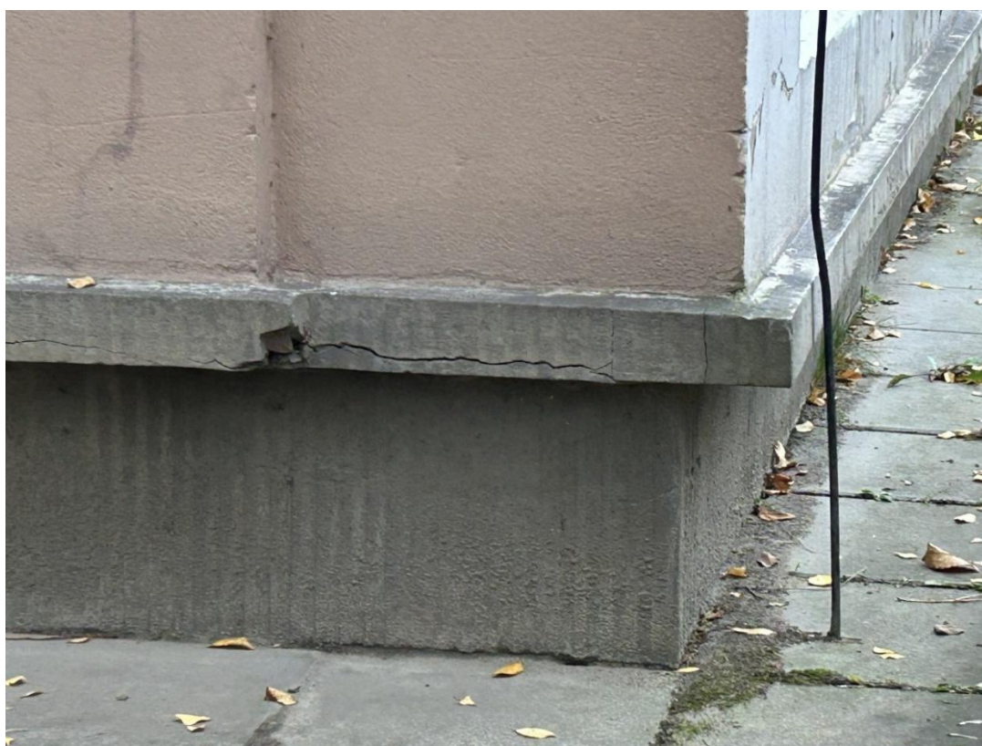
Widoczne spękania i rozwarstwienia a także głębokie ubytki na cokole kamiennym na elewacji frontowej („ B ”).
