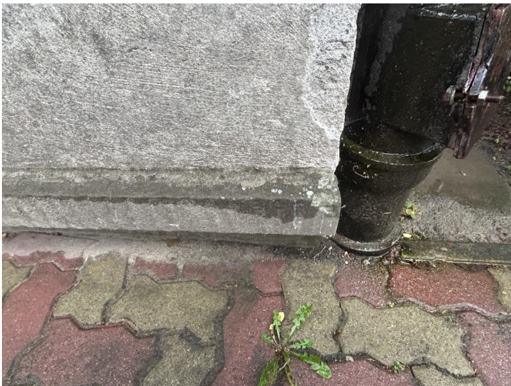
Widoczne zawilgocenia, mniejsze ubytki i skupiska mikroorganizmów na cokole kamiennym elewacji północnej („E”).
