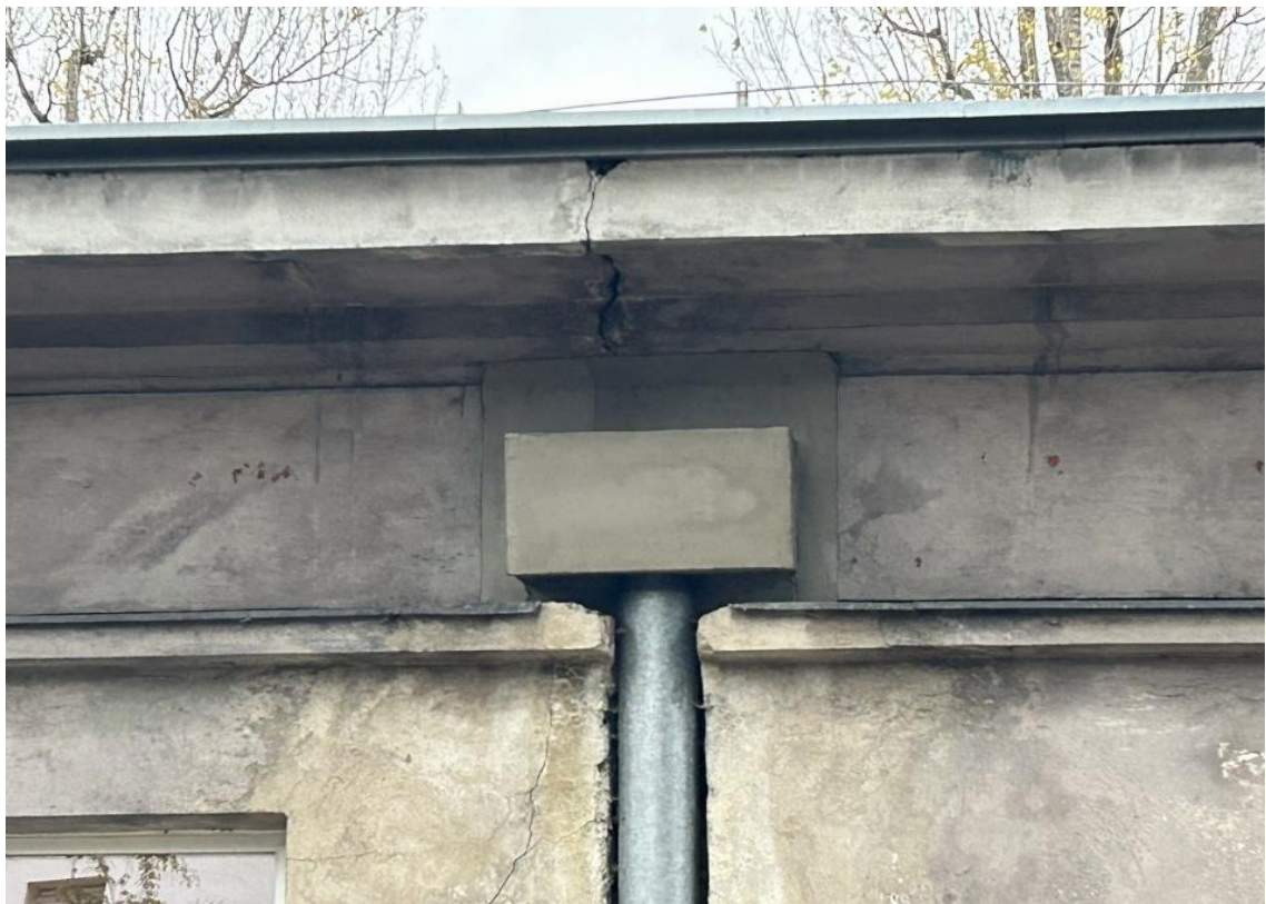
Głębokie spękania widoczne także na okapie elewacji północnej („E”).
