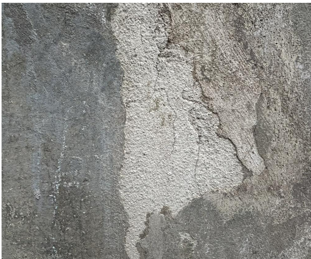
Tynk szlachetny, na elewacji północnej („E”), zachodnia część elewacji.
