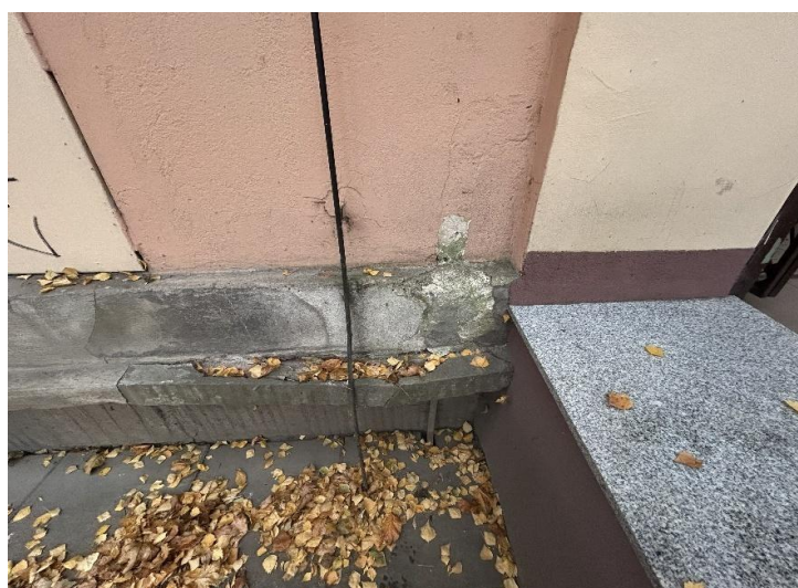
Widoczne rozległe ubytki w strefie cokołowej na elewacji frontowej, wschodniej („B”).
