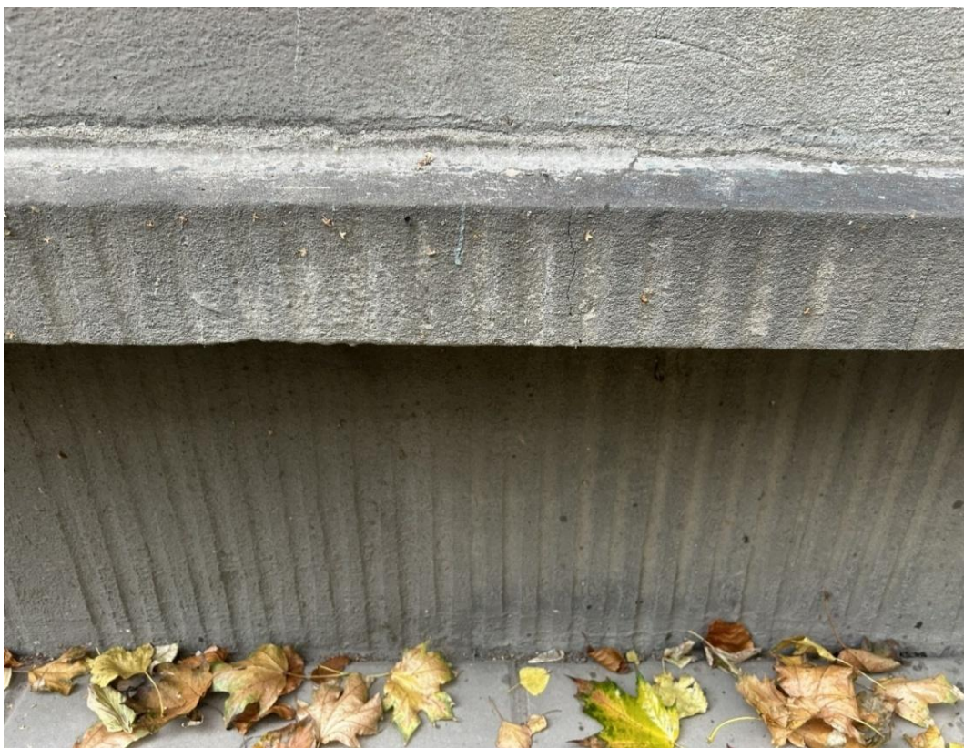
Ozdobny tynk kamienny na elewacji frontowej, wschodniej („B”).
