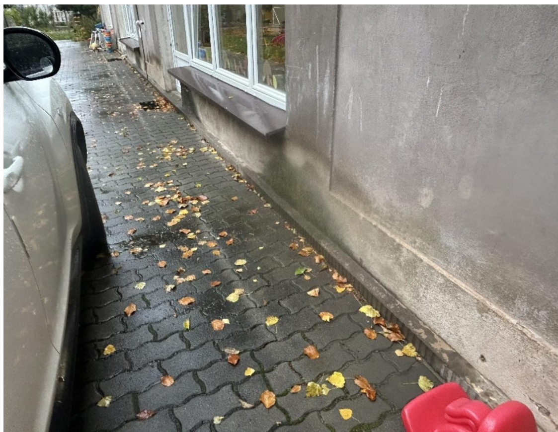
Widoczne zawilgocenia i przemycia tynków w pasie cokołowym na elewacji południowej („C”).
