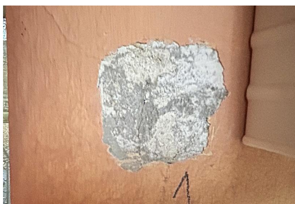
Odkrywka nr 1, pilaster zaokrąglony na bokach przy głównym wejściu.
