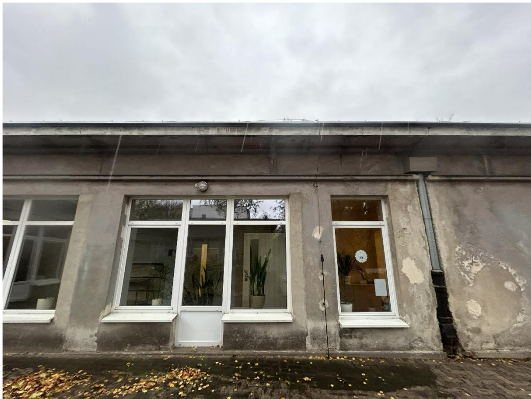
Widoczne rozległe zniszczenia na profilowanym okapie i górnym gzymsie, elewacji północnej („E”).
