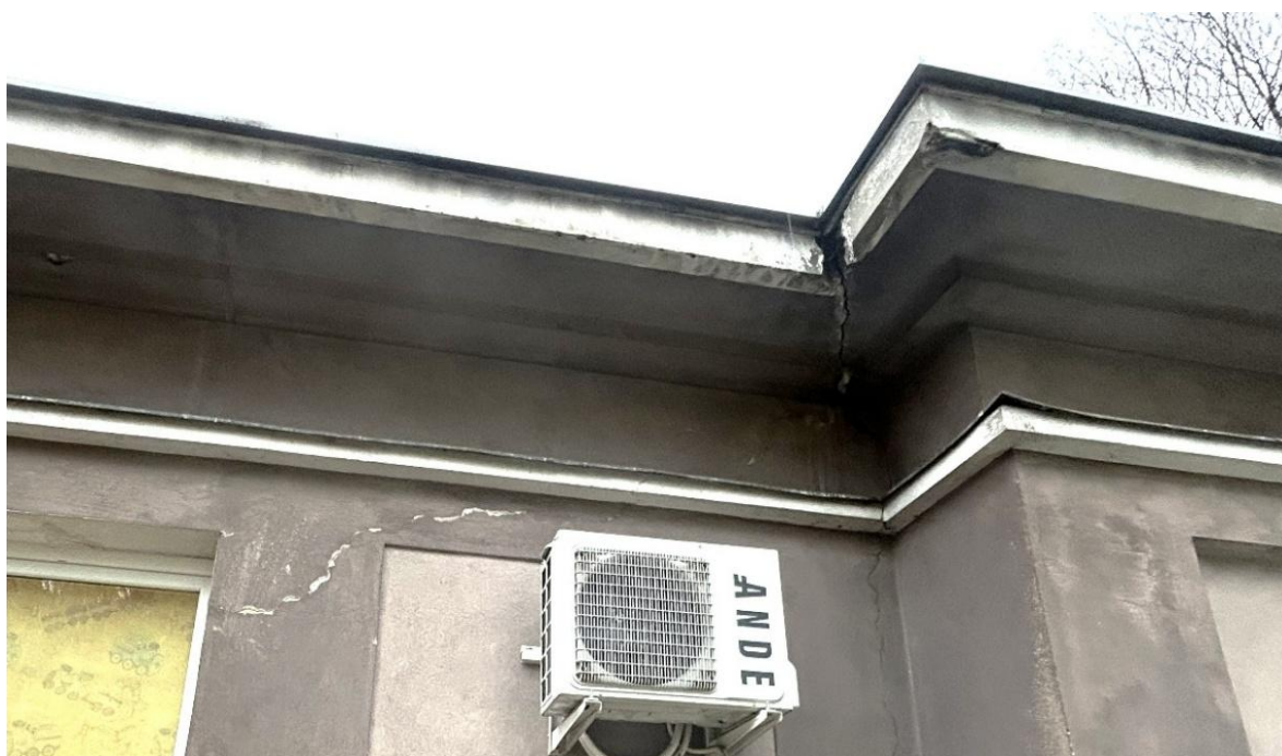
Widoczne jest bardzo szerokie spękanie na okapu oraz od niego głębokie rysy w tynku, biegnące w dół i na boki, na elewacji południowej („C”).
