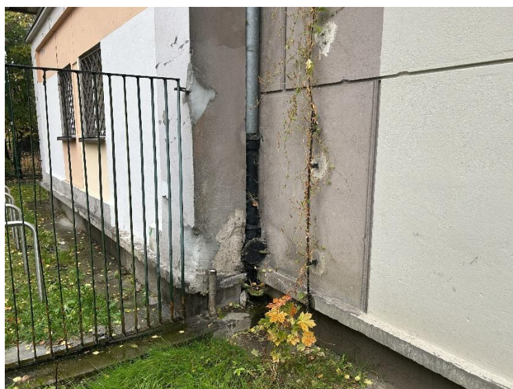
Widoczne zniszczenia wzdłuż rury spustowej na elewacji północnej („A”).
