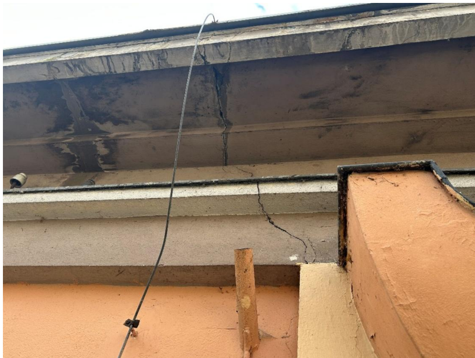
Widoczne spękania konstrukcyjne przy wejściu głównym na elewacji frontowej, wschodniej („ B ”).
