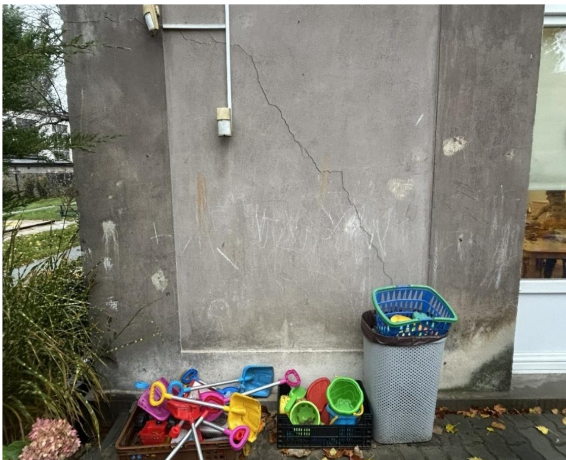
Widoczne skośne spękania konstrukcyjne na elewacji południowej („C”).
