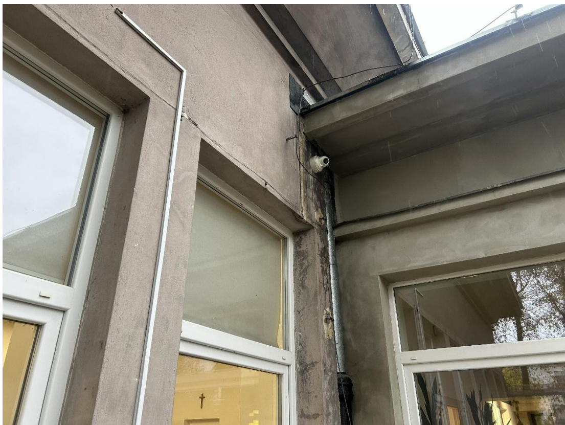
Widoczne ubytki, odspojenia w tynkach wzdłuż rur spustowych, również w narożniku elewacji („C” i „F”).
