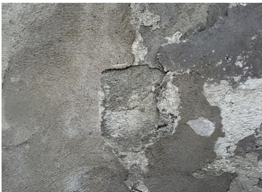
Odkrywka nr 6 wykonana na elewacji północnej („E”).
