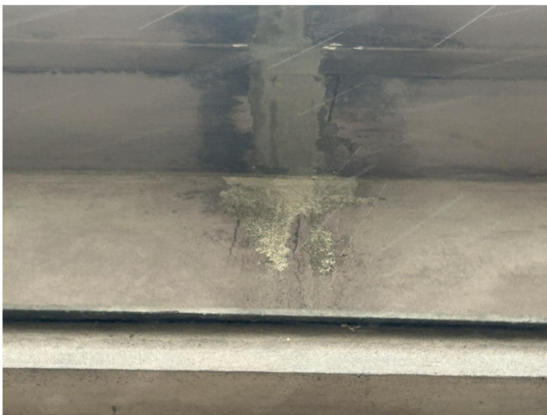
Widoczne duże ubytki w zaprawach i rysy na profilowanym okapie, elewacji północnej („ E ”).
