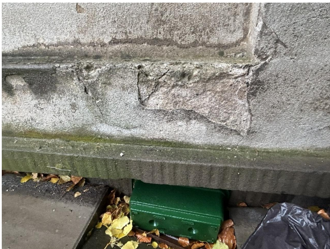
Widoczne rozległe ubytki, odspojenia oraz korozje biologicznej na elewacji zachodniej („D”).
