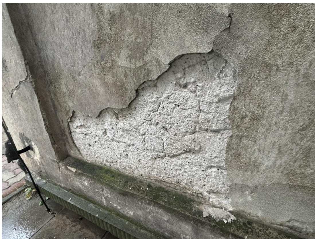
Widoczne odspojenia i duże ubytki odsłaniające tynki podkładowe pod spodem oraz korozje biologiczne na elewacji zachodniej („D”).
