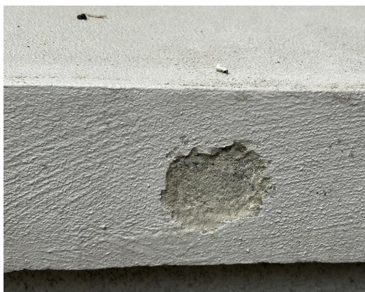
Odkrywka nr 11 wykonana na pokrywie murku przy pergoli.
